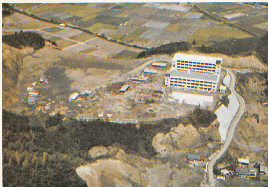
新校地校舎、鳥瞰景、校舎は第3期工事中 (昭和46年9月3日)
