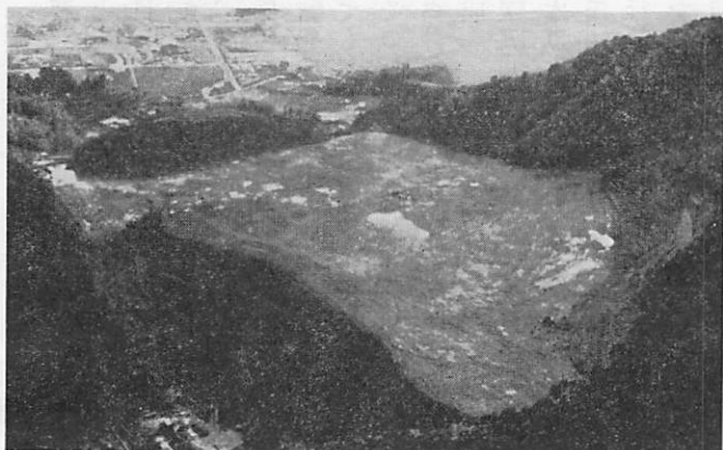
工事半ばになった新校地 (42.9中甸)
